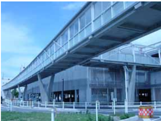
写真1 竣工した連絡デッキの外観
