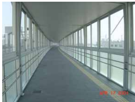
写真2 半径1,200mでカーブしたデッキ内部
