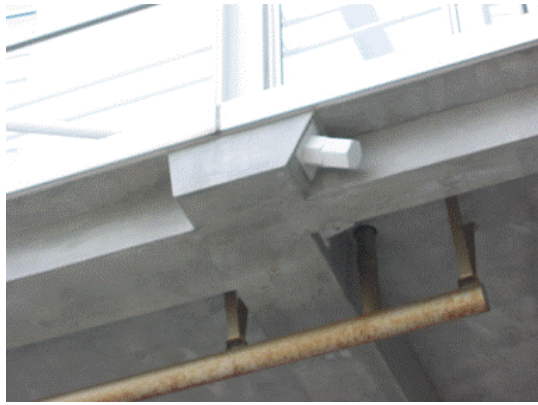
写真 14 現地に残ったロッド定着部 写真 15 現地から切り出して実験場に運んだ定着部
