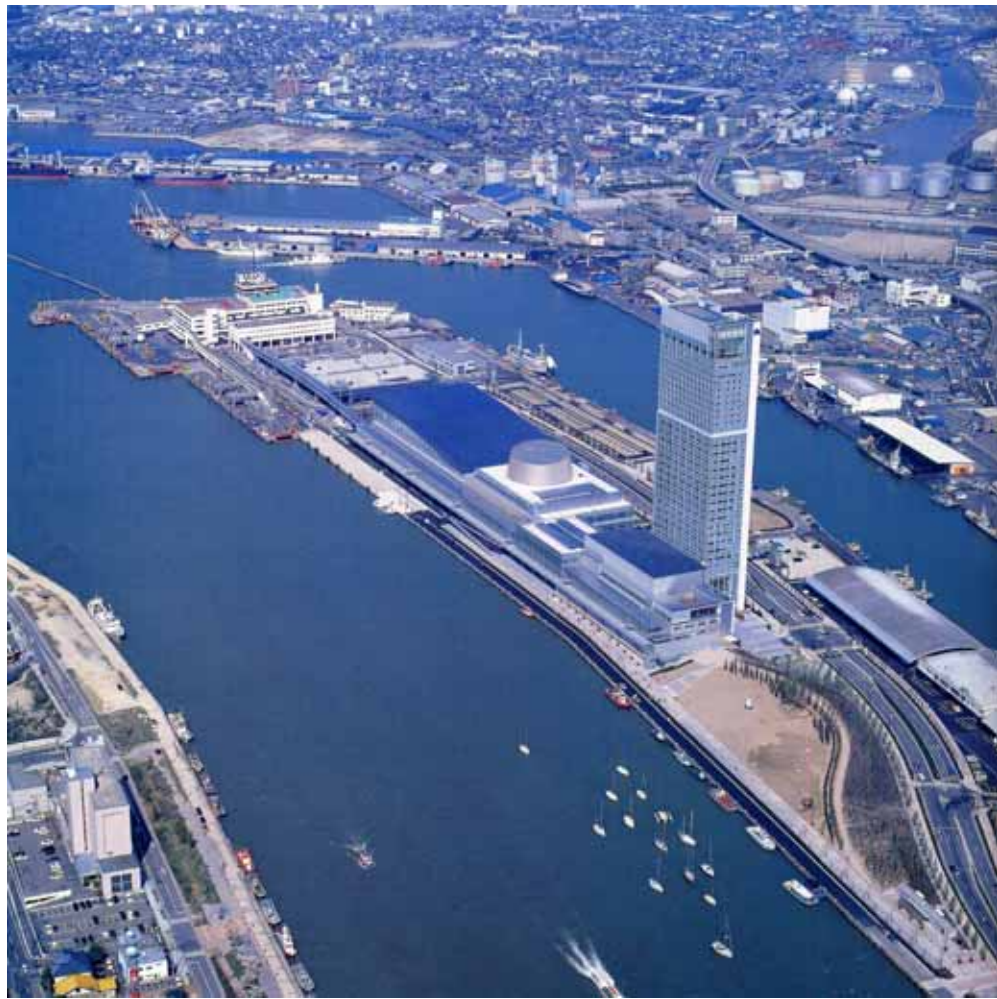
写真 3 完成直後の朱鷺メッセと連絡デッキ
